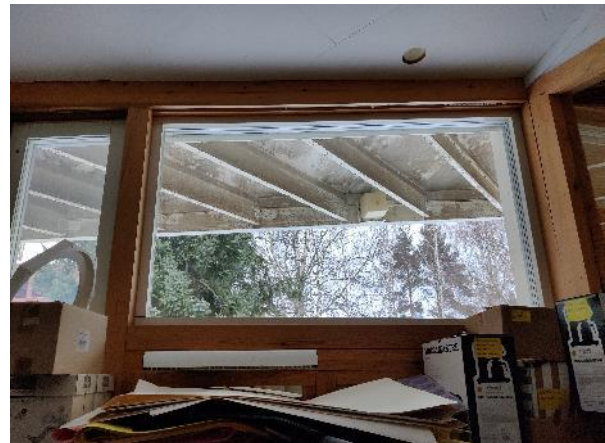
Kuva 10: Osittain ikkunat ovat kolmilasisia umpi-ikkunoita.
