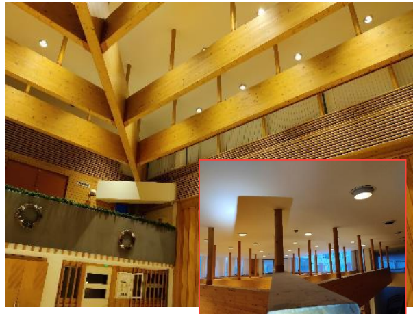
Kuva 47: Korotetun osan kattopalkkistoja, joiden päälle on kertynyt ajan kuluessa pölykerroksia
