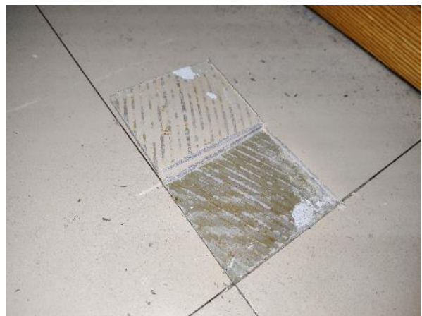
Kuva 26: Tilan 1022 muovilaattanäytteessä MNVO2 ei havaittu poikkeavia VOC-yhdisteitä tai niiden pitoisuuksia.
