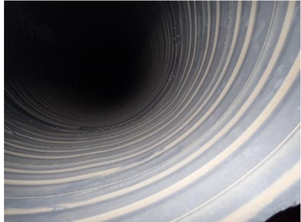
Kuva 57. Havaittavissa pientä pölyisyyttä sormipyyhkäisytestillä.
