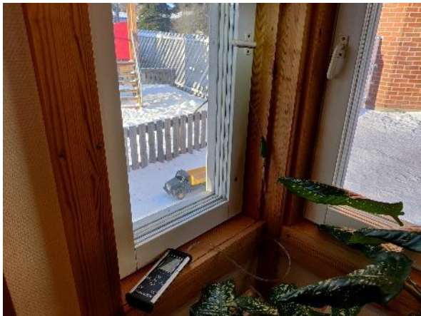
Kuva 9: Ikkunat ovat osittain sisäänpäin aukeavia kaksi puitteisia ja kolmilasisia puu – alumiini – ikkunoita.
