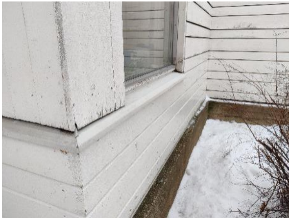
Kuva 13: Paikallisesti ikkunapellitykset ovat tiiviit, mutta kallistukset ovat loivia.
