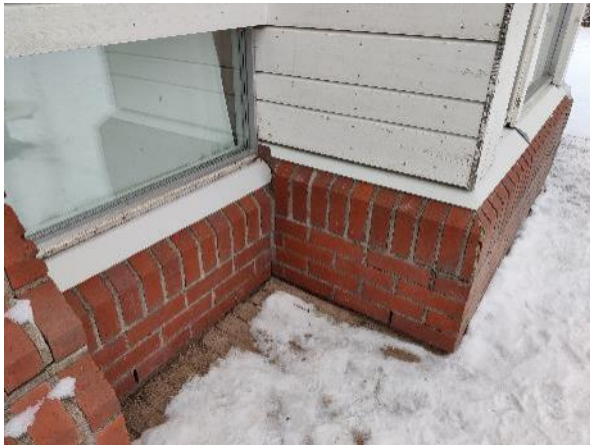
Kuva 30: Kosteusjälkiä tiilijulkisivussa.
