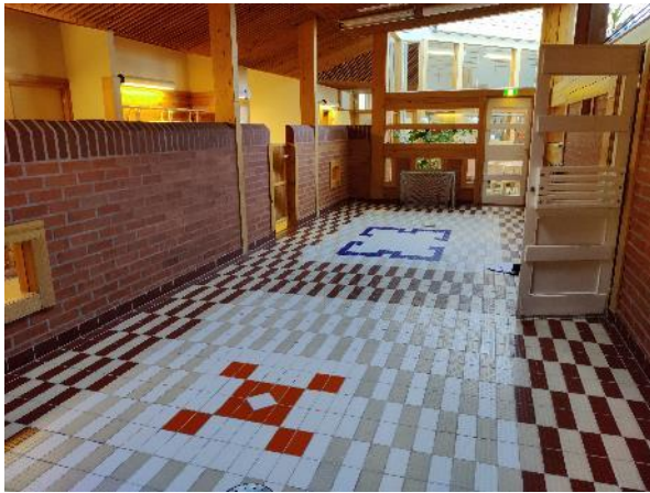
Kuva 38: Väliseinät ovat pääosin tiili- ja peltirakenteisia seiniä.
