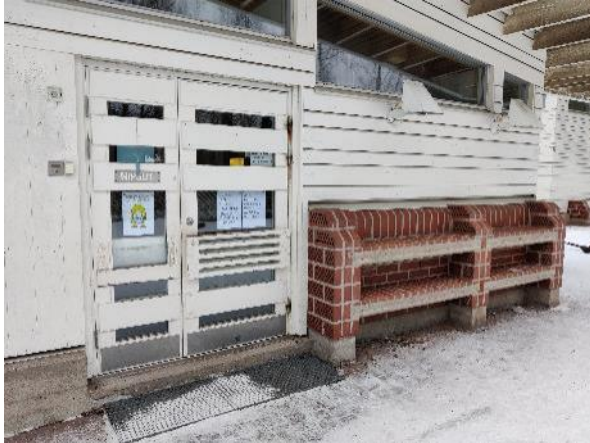
Kuva 7: Lasiaukollinen puurakenteinen ulko-ovi.
