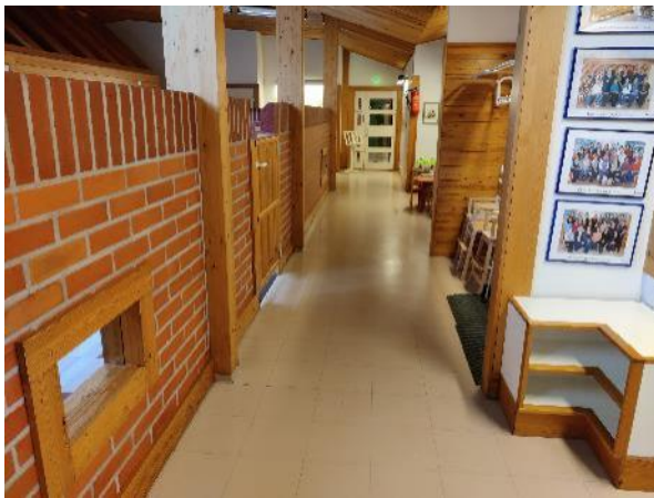
Kuva 15: Käytävötilöjien muovilaatoitusta.
