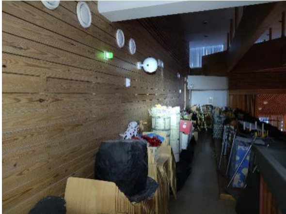
Kuva 42: Väliseinässä harvalaudoituksen taustalla avoimia villapintoja.
