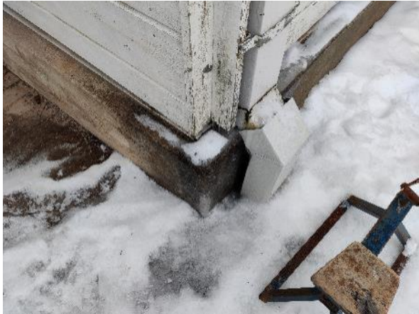
Kuva 4: Sokkelin betonin päälle kertyvää lunta.
