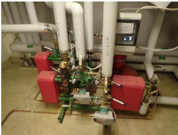
Kuva 64. Kaukolämmön alajakokeskus.
