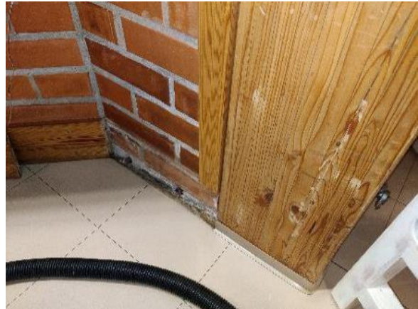
Kuva 28: Lattian ja tiiliväliseinien liittymät vaikuttavat tiiviiltä.
