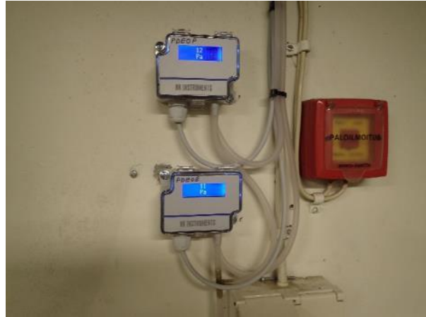
Kuva 51. Rakennuksen vaipan yli mitataan paine-eroa jatkuvalla mittauksella.
