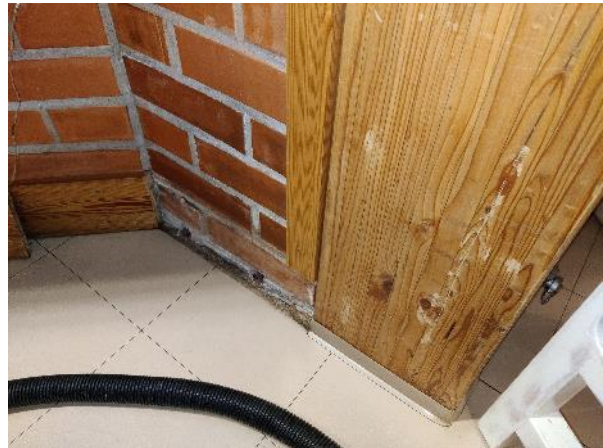
Kuva 39: Puupilarit ovat usein osana väliseiniä.
