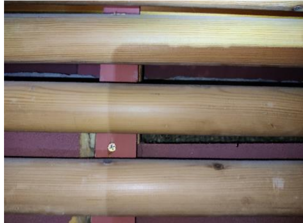
Kuva 43: Puuritolönnin taustalla akustolevytyksessä avoimia leikkauspintoja.
