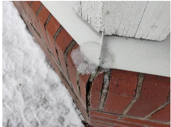
Kuva 31: Kosteusjälkiä tiilijulkisivussa.
