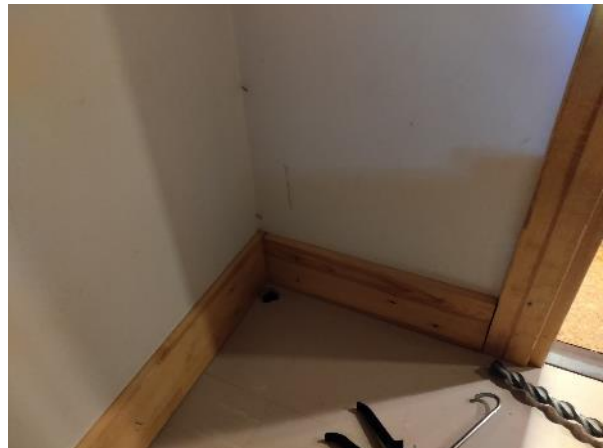
Kuva 41: Peltirankaiset seinät ovat kipsilevytettyjä ja maalattuja.
